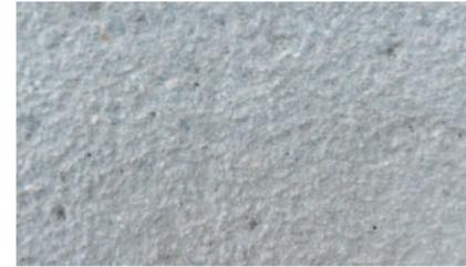
Die Körnung der sandgestrahlten Oberflächen darf maximal 8 mm stark sein
