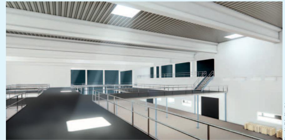
Im Gebäude wird eine 4,60 m hohe, circa 1.200 m<sup>2</sup> umfassende und mit Hubwagen befahrbare Stahlbühne errichtet
