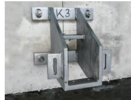
Im ersten Schritt werden Edelstahlkonsolen sowie Windverankerungen eingemessen und montiert
