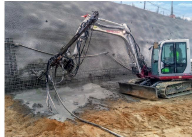
Zur Hangsicherung wurde eine Spritzbetonwand von 3.000 m<sup>2</sup> Fläche angelegt
