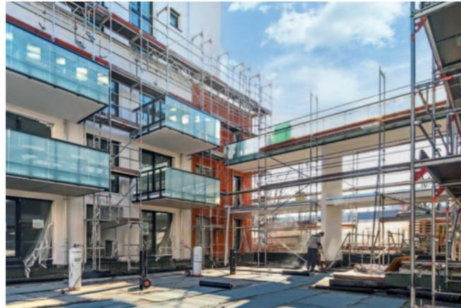
Die Gebäude entlang der Zuffenhauser Straße sind über die Balkone und eine durchgehende verglaste Lärmschutzwand verbunden
