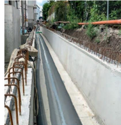
Der Kanal wurde komplett neu gebaut – bei im wahrsten Sinne laufendem Betrieb
