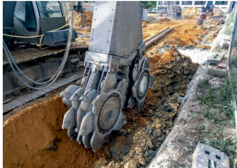
Beim Bauvorhaben DKV kam das CSM-Verfahren (Cutter Soil Mixing) zum Einsatz
