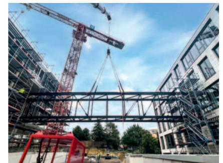
Als ein zusammenhängendes Element wurde die Brücke zwischen Alt- und Neubau eingehängt
